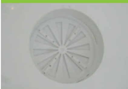
6.21 Fixierte Rosette für den Luftdurchlass an der Trennwand (800 mm x 150 mm)
