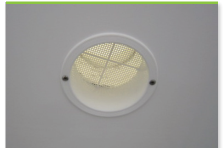
6.18 Runde Rosette, fix montiert, D 150 mm (verschießbar)
