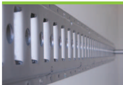
5.8 Alu-Ankerschienen zur Befestigung der Absperrstange
