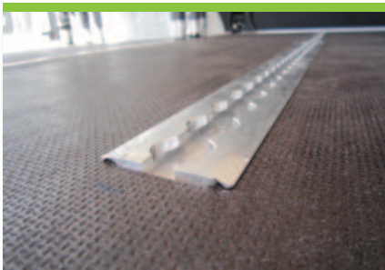
12.3 Alu-Ankerschienen zur Aufhängung der Absperrstangen
